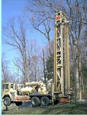
เครื่องเจาะบ่อน้ำบาดาล
