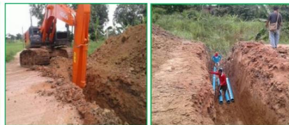
ขุดวางแนวท่อและติดตั้งวาล์วเปิดปิดรับน้ำ
