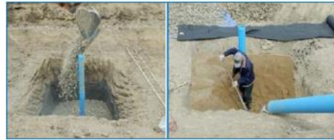
การจัดทำระบบกรวดทรายกรองของบ่อเติมน้ำ
