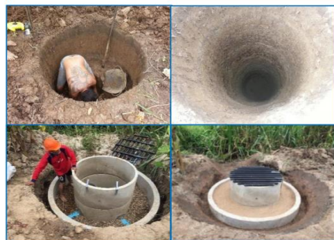
การก่อสร้างบ่อเติมน้ำ (บ่อวงซีเมนต์)
