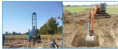
การเจาะบ่อเติมน้ำและขุดสระของบ่อเติมน้ำ
