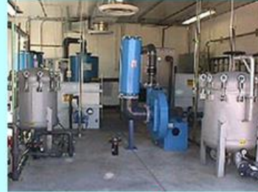
อุปกรณ์บำบัดน้ำบาดาล
